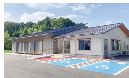
▶ 幾世橋小学校の跡地に整備された、幾世橋防災コミュニティセンター
