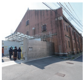
▲ 旧広島陸軍被服支廠を視察
